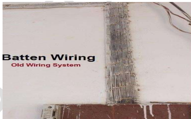
(Fig.5.3. Batten Wiring)
